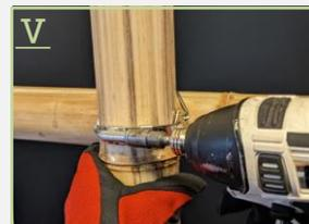
V クランプの仮締めが全て完了したら全体のバランスを整えながら本締めします。強く締め込みすぎるとクランプが破損しますので注意してください。
