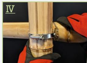
IV 竹の結束部位にクランプを通しインパクトドライバーで仮締めします。竹の締め付けはプラスドライバーではなく六角のソケットレンチを使用します。
